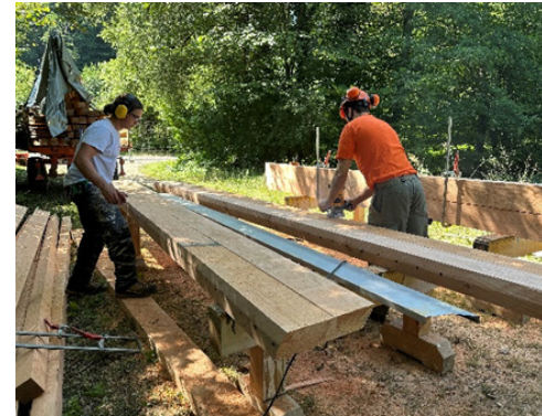
Die neue Dättwiler Brücke aus Douglasien, die ca. 2 Km entfernt gewachsen sind.
